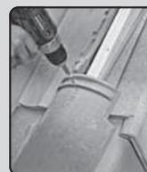
Просверлить желобчатую черепицу с головной части, установить для покрытия и прикрепить к обрешетке крыши саморезом.
