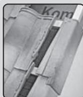
Между последним рядом черепицы для покрытия поверхности и черепицы свеса справа при разметке следует учитывать около 60 мм.
